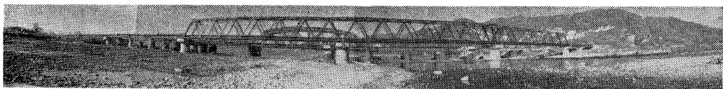
上り線が完成した信越本線犀川橋梁
