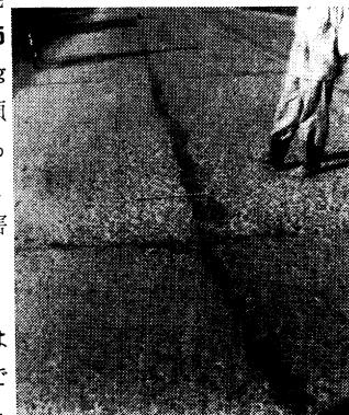
写真-6 開キヨの被害状況
