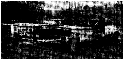
写真-3 冷凍管付きの絶縁蓋の設置
