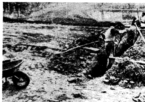
写真-3 悪い締固めのためできた穴
