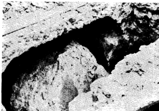
写真-3 悪い締固めのためできた穴
