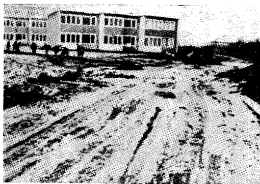
写真-2 縁石施工後に掘削し、地下埋設物を施工
