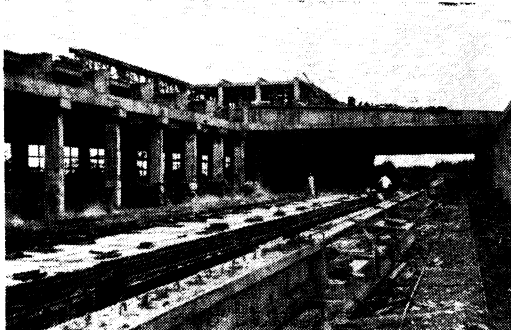
写真-12 台東パイナップル工場、 プレテンション ベンチ
