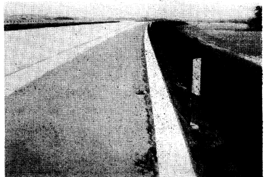
写真-8 西ドイツ・アウトバーンの防護柵と反射柱
