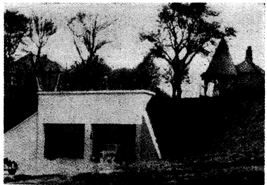
写真-11 撒布剤置場
