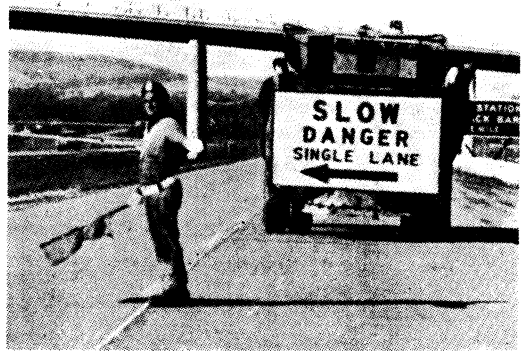
写真-4 ニューヨーク・ステート・スルーウェイ 補修工事の際の信号手とトラックにつけられた警戒標識
