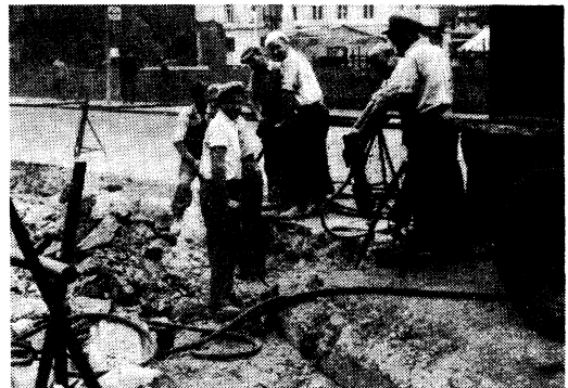
写真一6 ロンドン付近道路舗装補修工事
