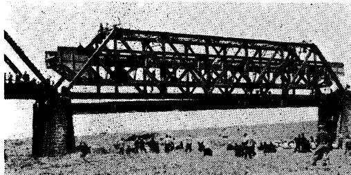
架替工事中の雄物川橋梁
