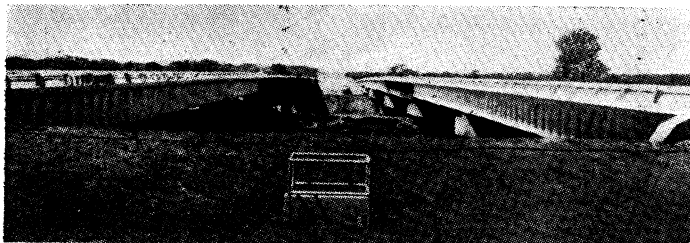
写真一 Verdigris 河 横断 橋梁
