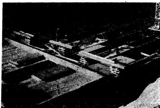
サマラバラージかんがい用水取入暗渠 (西独建設業者施工中)
