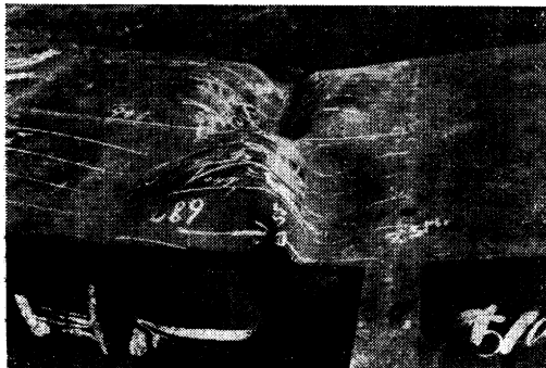
写真-4 箱桁の座屈状態
