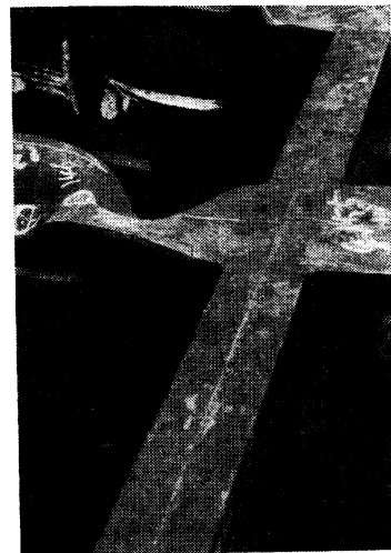
写真-3 中央 I 桁の座屈状態
