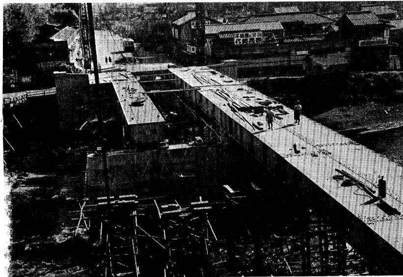
←箱桁の架設：1スパン2カ所の支保工上に箱桁を架設してゆく。向つて右側の桁はかけ終り、今左側の桁をのばしている。桁端のダ円孔はマンホールである。
