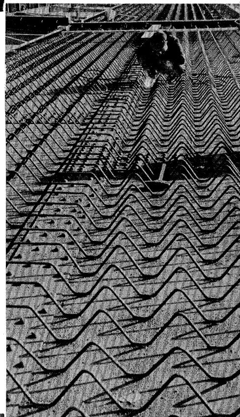
←箱桁の内部：横桁位置のダイヤフラムおよび中間ダイヤフラムとデッキプレートのリブとの交叉する状態がみられる。
