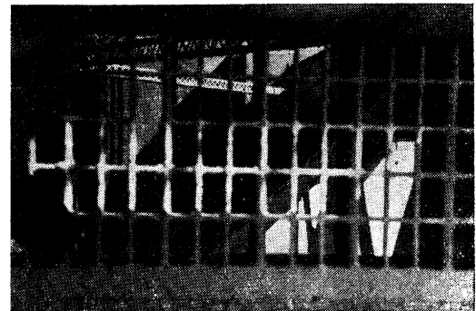
写真-5 New Tacoma 橋の橋床部のグレーティング
