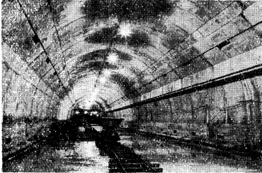
写真三 海底部人道 (幅員 3.8m, 高さ 2.5m)
