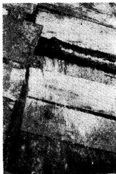
写真-2 圧気前、導坑切羽
