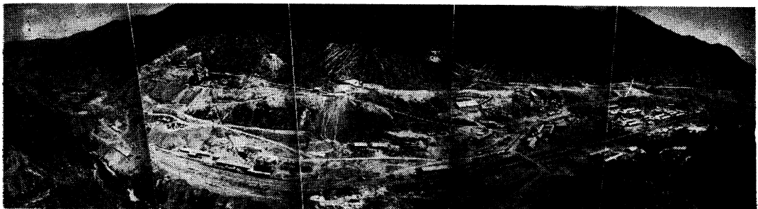
写真—1 ダム工事全景 (昭. 29. 6)
