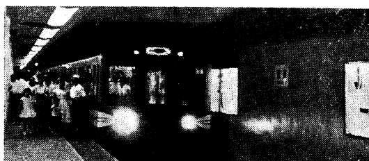
写真三 完成した地下鉄東京駅ホーム
