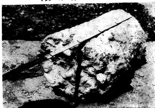
写真-10 杭頭部断面
