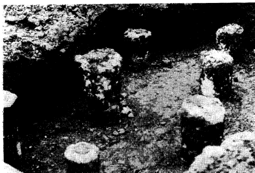
写真-9 掘り出されたプレパクトコンクリート杭
