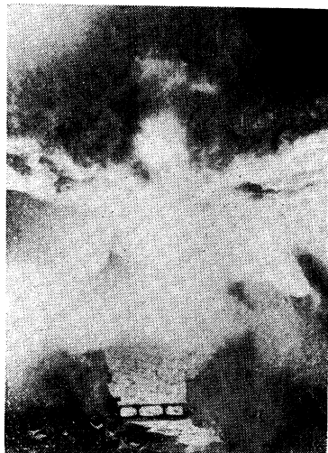
写真-3 昭.30.10.12. 放流実験時余水吐ジェット衝突状況(ダム天端より下流をのぞむ)
