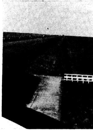
写真-1 締切堤防
