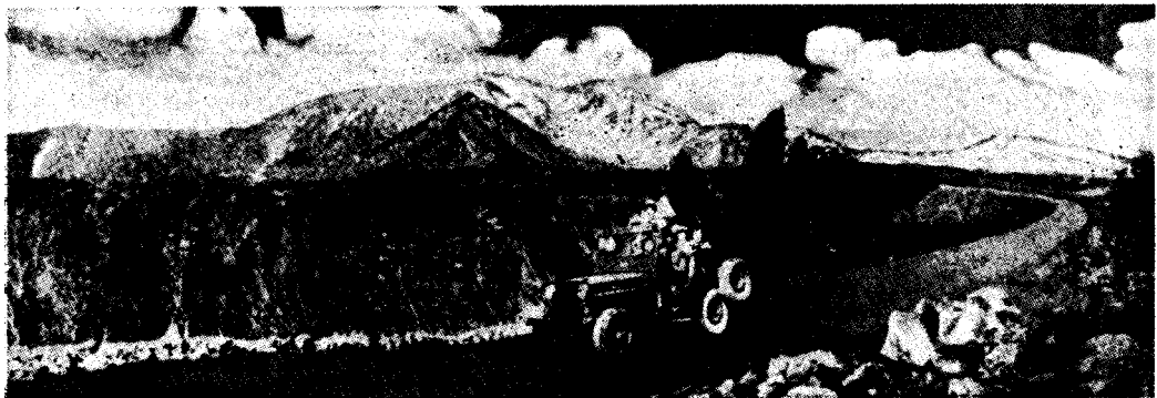
写真-2 立山有料道路(中部支部)
