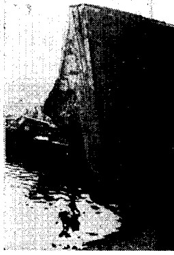
写真-3 防潮堤倒壊 西側断面
