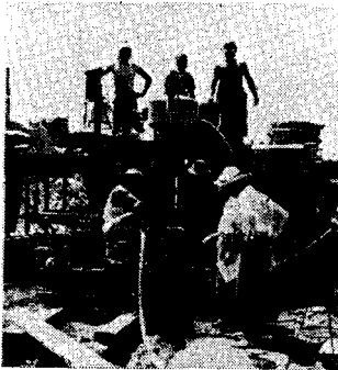
写真-6 グラウトポンプ
