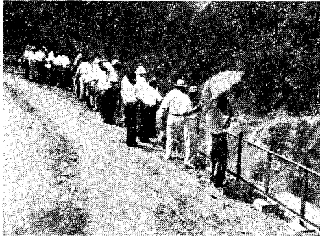
写真-5 宮川ダム建設工事
