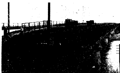
写真-51 Ponte sul Po a Mezzanacorti (Milano—Genoa Line)
