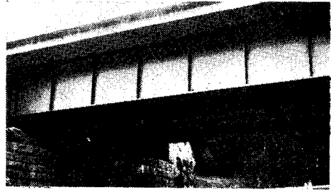
写真—32 Eisenbahn Brücke bei Gutach (合成桁支間 28.6 m)
