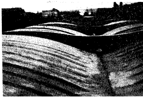
写真-46 München 交通博覧会場内の Hall (側支間 10\text{ m} + 主支間 30\text{ m} , Shell の厚さ 6\text{ cm} )
