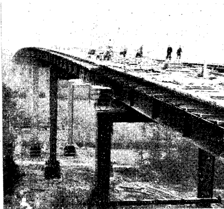
写真—31 Sulzbach-Viaduct Brücke
