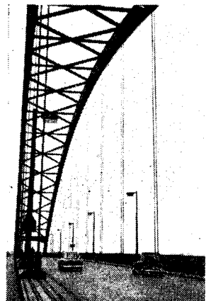
写真—33 Duisburg-Rheinhausen Brücke
