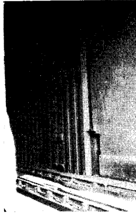
写真—6 Britania Tubular Bridge の支点上内面 (精巧な鑄鉄の巨大な枠が見える)
