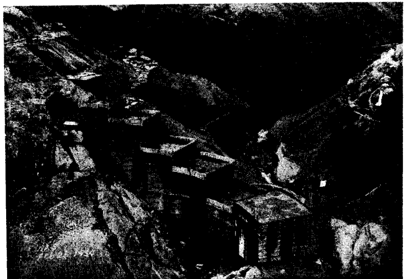
写真-1 工事中の上椎葉アーチダム (昭.29.2.26.撮影)
