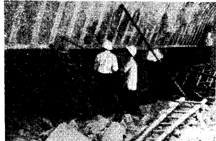
写真-8 橋台内部
