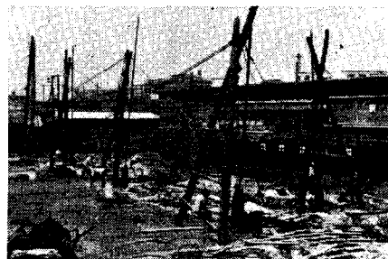
写真-4 二股5台により作業中
