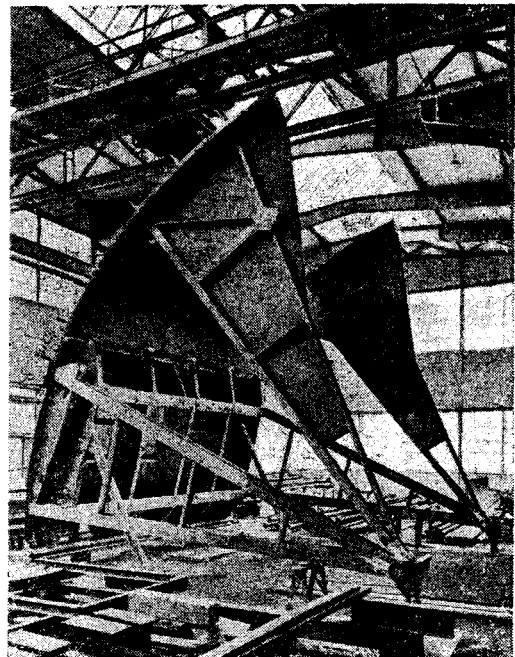
写真-1 Rossens 発電所のテンターゲート
