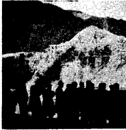
(右岸より工事現場を見 る一行、前方は左岸の Cable crane の tower)
