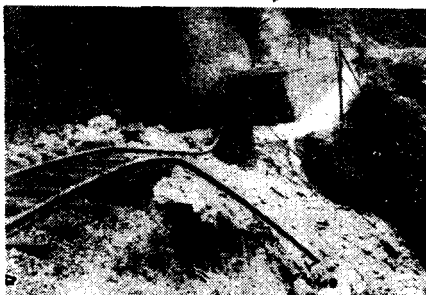
写真—12 同第一羅天橋梁流出
