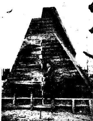
写真-2 防潮堤擁壁の背面
