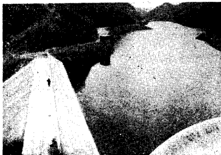
註: 手前に餘水吐, 向側に取水口が見える
