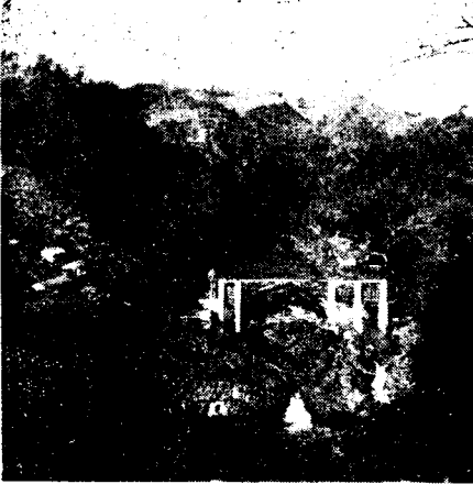
写真—3 押方川水路橋
