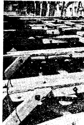
写真-4 横 桁 配 置 状 況
