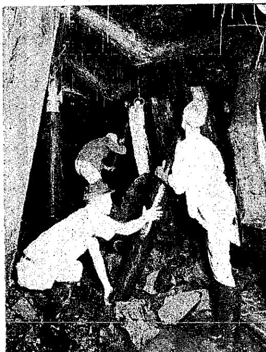
關門國道隧道は延長三四五〇メートルの導坑と極く一部分の切掘げ、覆工が完了しただけで工事は行き詰みの状態になつてゐる。二十二年度は僅かに腐蝕支保工の取替へ、隧道口の掘鑿、水路付替へ及び堅坑底より左右へ延長八メートルの切掘げ、覆工のみが計画された。
