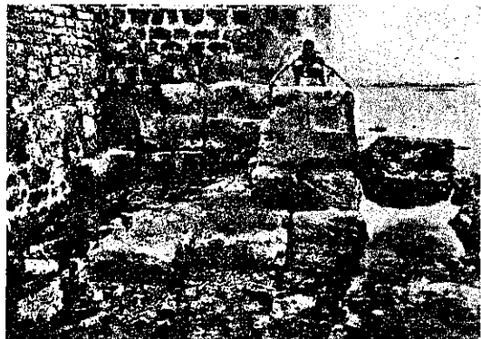
圖-11. Sidon 港の防波堤の基礎
