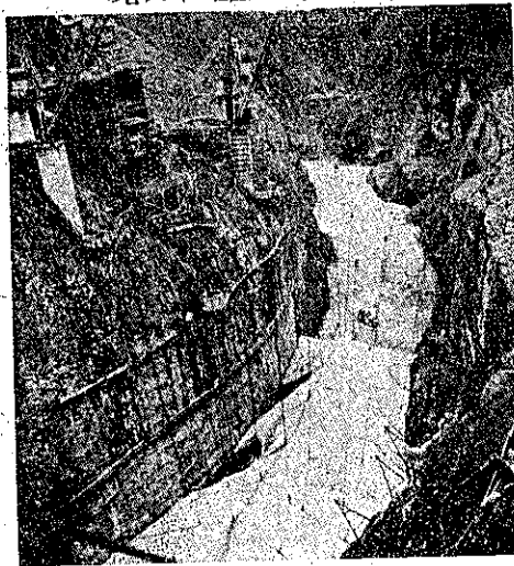
圖-18. テントの圓・デリックはバケット(左中央に見える)を昇降口を通して降す。雨樋を兼ねた歩道が溪谷端の各テントの位置にある。
