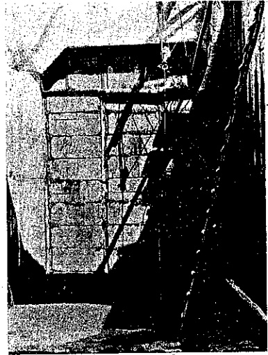
圖-10. D 10 の假外壁(取壊中)
