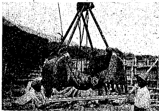
圖-12. グラブ・バケット (容量 0.5 \text{ m}^3 )
