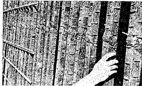
圖-21. 熔接の出来上り、熔接者は繩手に自身のマークを付ける。約100熔接毎に試験して、其の強度が母材強度の80%を要請されてゐる
