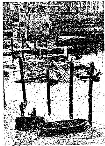
圖-70 破棄された橋の破屑の間にフランジの廣い型鋼の杭を打込んだもの
