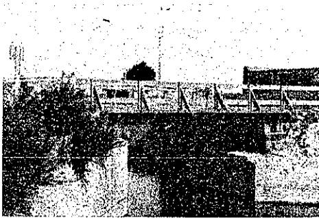
圖-56. 破壊された橋臺の處に木架を作つて架けた歴延鋼桁上構の橋床
