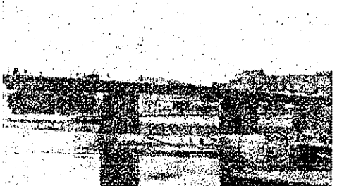
圖-65. 木柱脚上の鍍付化の柱脚は石橋の橋脚の殘りの上に建てられたものである。鍍桁は敵地の新に操業を始めて製向所に於て 19 日間で製作されたものである
