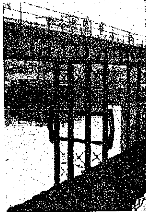
圖-66 或る大都市に於ける耐久性の假橋 此の假橋は新たな位置に作った鋼矢板の柱脚上に銲桁と構を架したものである。
