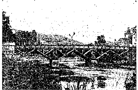
圖-63. トラスに組んだ三角型方杖で舊橋の位置に架けたものである。充腹合成桁を用ひてゐる
