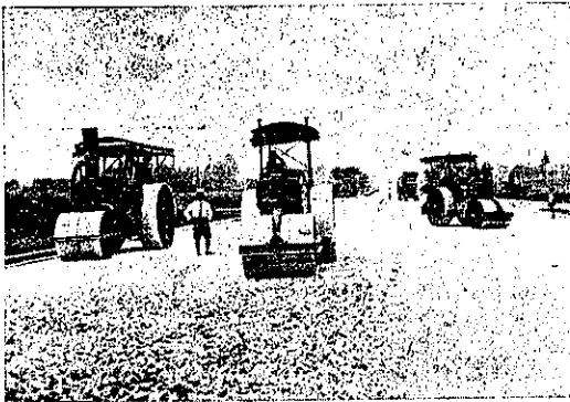
圖-8. 碎石基礎輾壓作業
