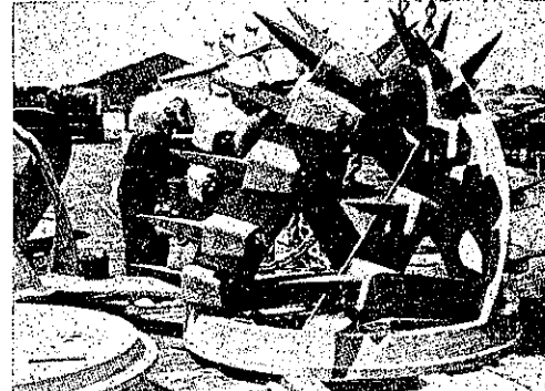
圖-39. ポンプ浚渫船“Welatka” 號のカッター（逆螺旋型）
