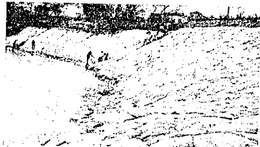
圖-31. 袋詰め土セメント混合物の施用例
