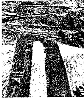
図-25. 羊脚型ローラーによる 縦圧、方向転換の方法に注意。
