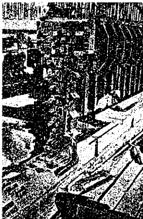
図-85. 腹部及上突縁型枠
