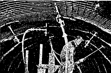
図-29. 内部空孔検出の爲めの穿孔、ホースを連結したものは挿入物質用及圧搾空気用の孔である。
