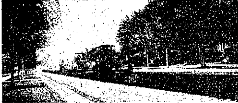
図-96. Colorado Springs 通り表装の爲、モーターグレーダを用い油と骨材を混合せしめて居る図。
