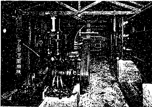
図-9. 水路第1號横坑内アムモニヤ式冷却機
