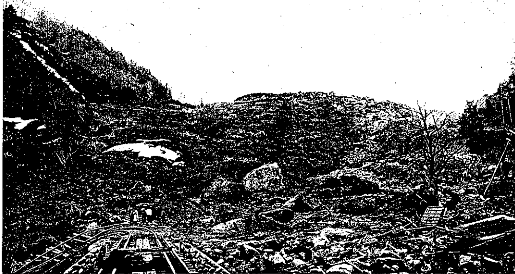
親ノ澤橋梁附近に於ける崩壊土砂と線路の被害状況。
