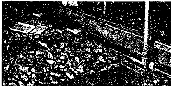
図-11. 管子隧道内に於て軌條底部タイプレート間に 理研のアルマイト製絶縁板を挿入せる状況
