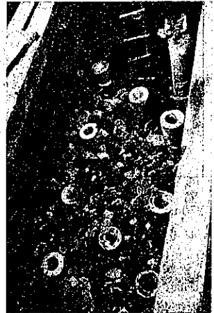
図-4. 高架橋基礎に鉄筋コンクリート中空杭を打つた状況
