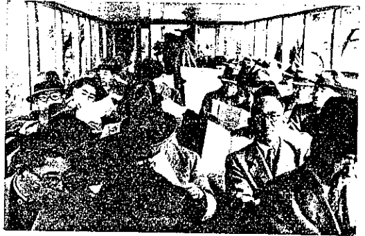
圖-3. 立石發電所休憩所
