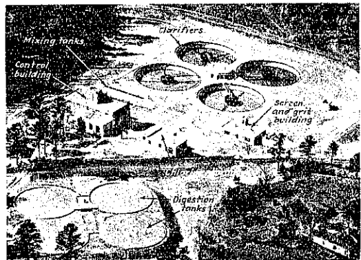
圖-31. Clayton 處分場(隨時藥品沈澱を行ひ得る 豫備處理設備を有する。堤防は洪水防禦のため)
